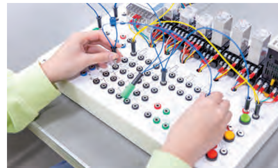
シーケンス制御の実習装置で配線作業を行う綾塚さん。シーケンス制御は、冷蔵庫や洗濯機など身近な家電製品に使われている技術。写真の装置は上條研究室で製作。
